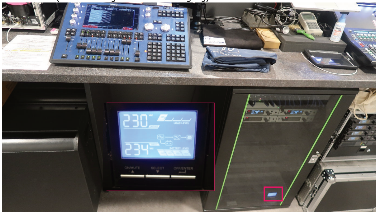
Bild 2 - USV (unterbrechungsfreie Stromversorgung)
